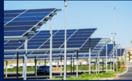
Ombrières de parking
