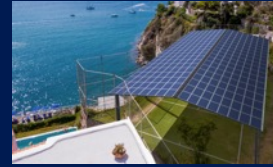
Préaux Photovoltaïques pour terrains de sport
